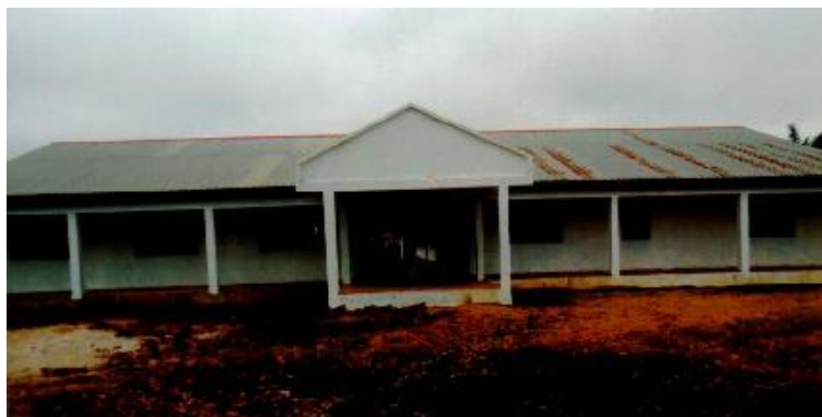
Construction de l'hôpital de base (H1R) de Lékana (Plateaux) : arrêtée depuis décembre 2014. Photo prise le 29 juillet 2015.
