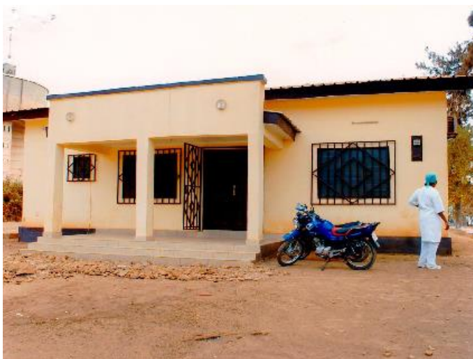
Construction de la pharmacie de la CSS de Nkayi – Loudima (Bouenza). Le bâtiment est achevé et fonctionnel. Le personnel alerte cependant sur le manque d'équipement et de communication autour du rôle de la structure dans la région. Photo prise le 18 août
